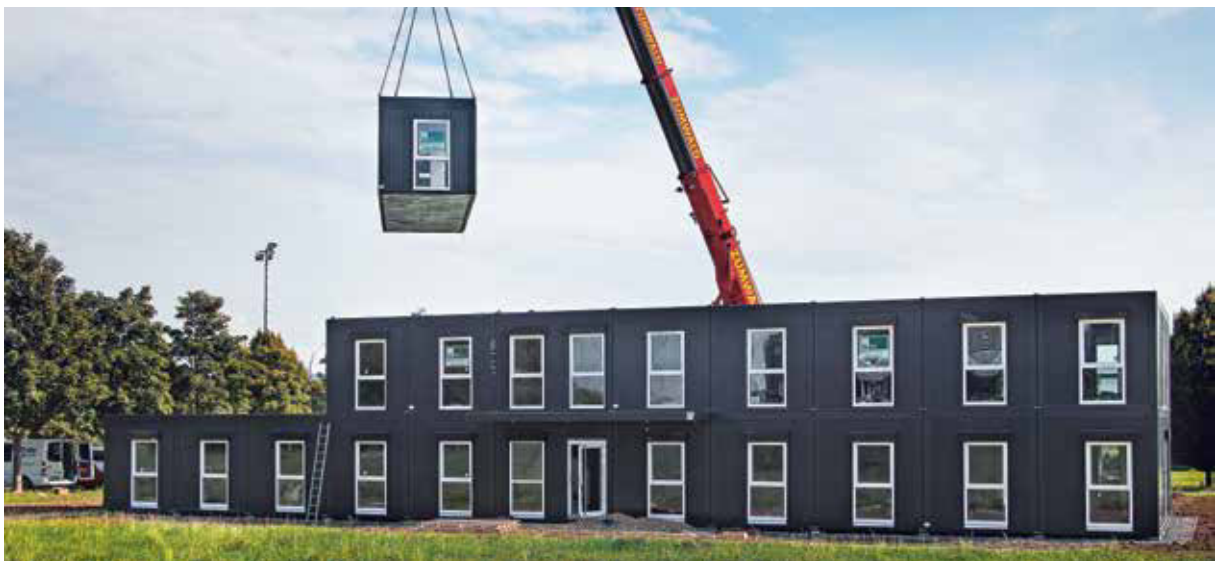
Versetzen der Container
