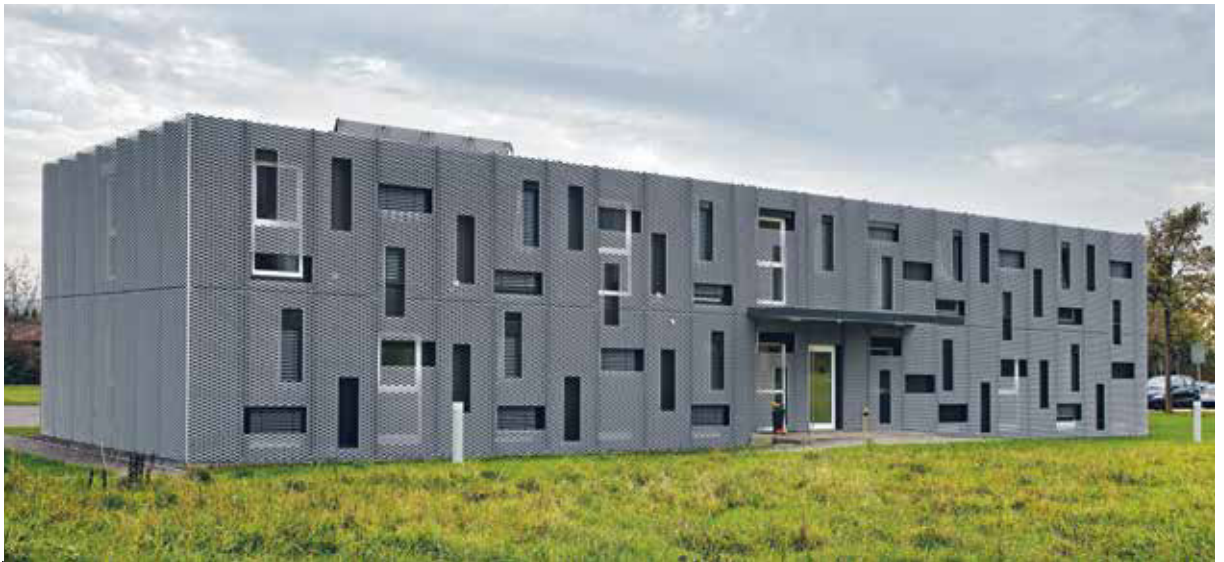
Nordfassade mit Haupteingang
